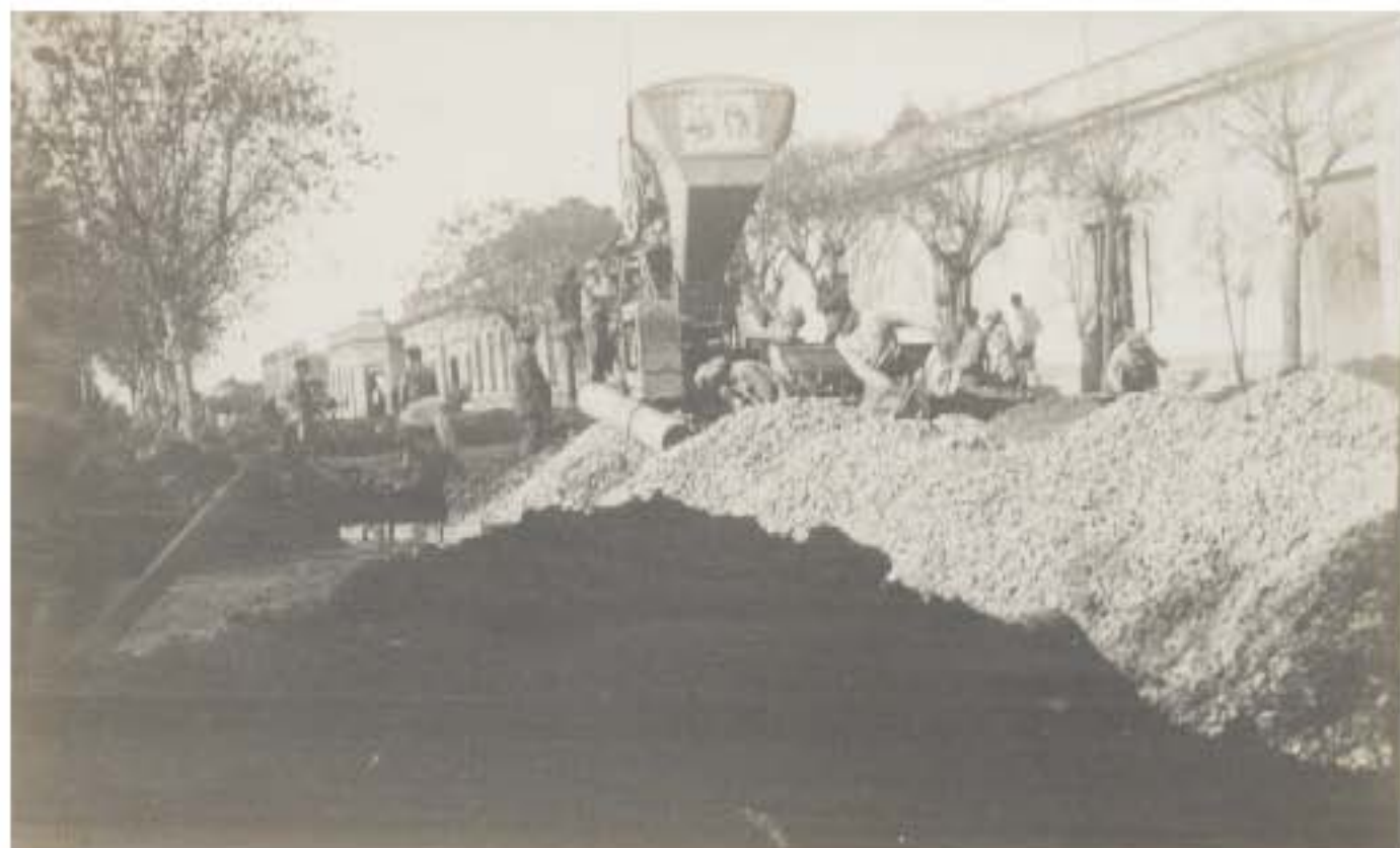
Pavimentando varias calles con HORMIGÓN
